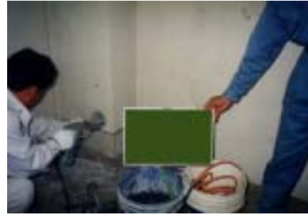
コンクリートをはつり鉄筋の状態を確認
