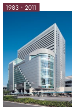
大阪ステーションシティ・ サウスゲートビルディング Osaka Station City South Gate Building
