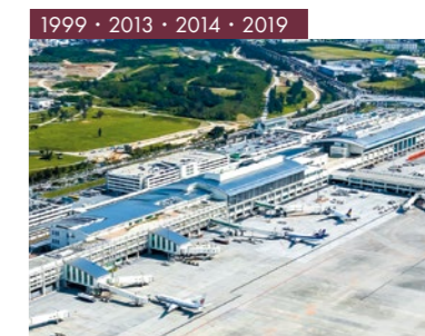
那覇空港旅客ターミナル Naha Airport Terminal Building
