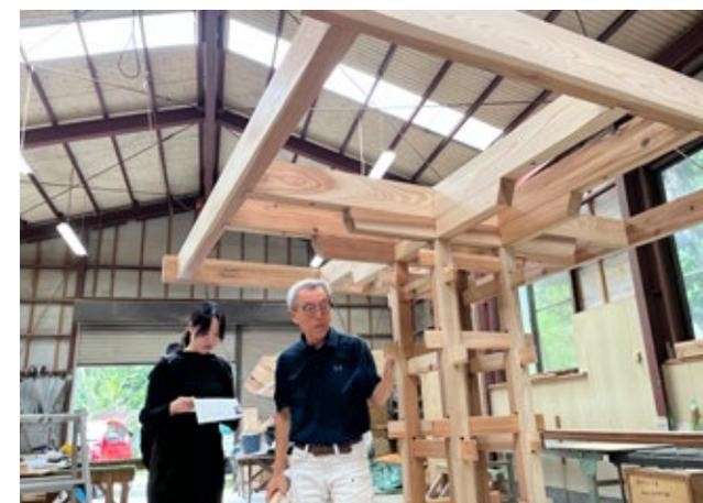
工務店では1/2サイズのモックアップで納まりを検討、貫工法で木材を組み立てる様子を見学。
