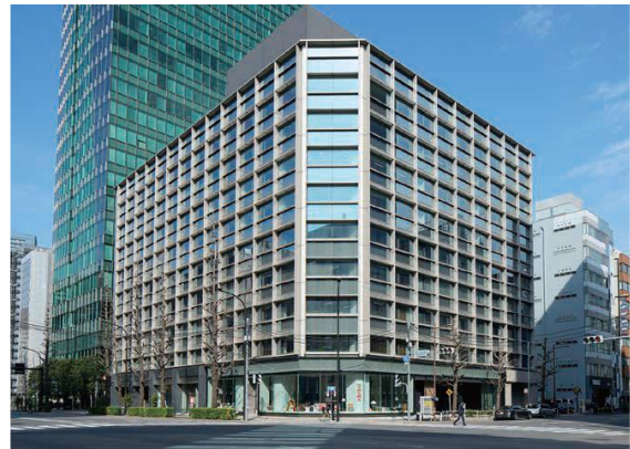
2002年外装・耐震改修、2024年一部外装・内装・設備改修
