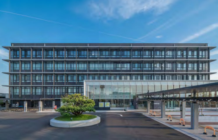
半田市庁舎は、南海トラフ巨大地震に備えた画期的な接続型スイッチダンパーによる免震構造と、津波・高潮対策として計画床レベルを上げた設計により、災害対策拠点・緊急避難施設として機能する防災力の高い庁舎です。
