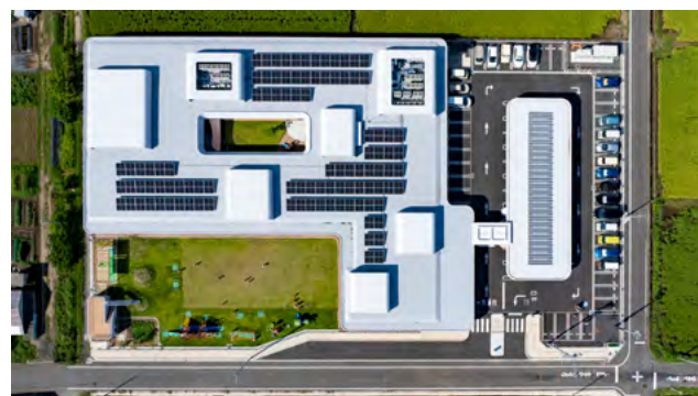
農作物を生産する田圃地帯に囲まれた園舎の屋上は、建物で利用する電気も太陽光から生み出す第二の大地となっています。
