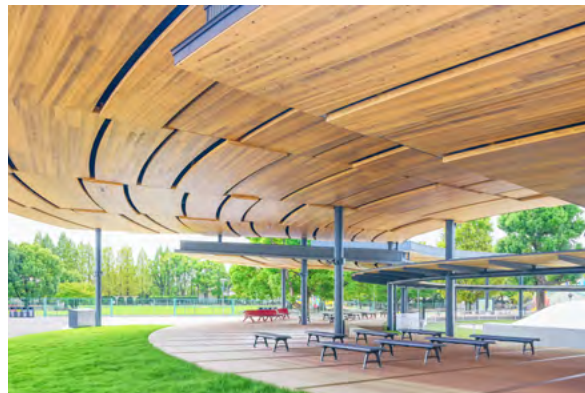
京都競馬場 木もれびテラス。 木のぬくもりに包まれて心地よく滞在できる空間です。CLTにより、環境に配慮しつつ屋根面の剛性を合理的に確保しています。
