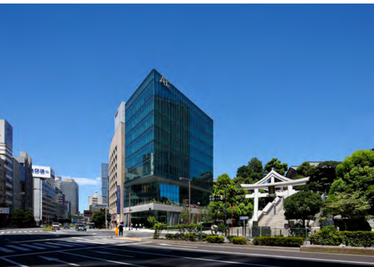
エービーシー商会本社ビルには、屋上に建物自重の4%にあたる100トンの地震用TMD（同調質量ダンパー）を設置。地震後の後揺れを半減、天井レス構造で地震時の落下物に配慮、役員フロアや大会議室等で3日間業務継続可能なBCP機能を備えた高度な耐震・防災性能を実現しています。
